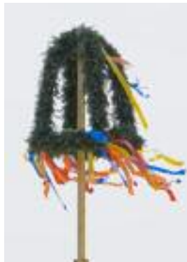
Im eisigen Wind - die Richtkronen auf dem künftigen Bootshaus des ELSTERPARKS.
